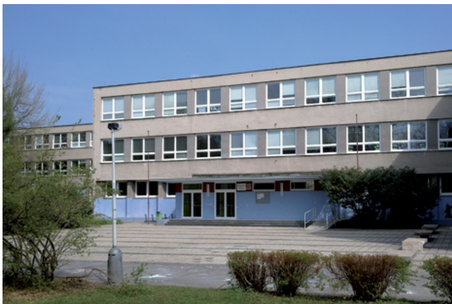
Také ZŠ Novoborská prošla rekonstrukcí.
